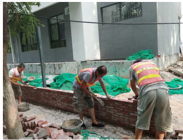
附属学校北侧道路施工
