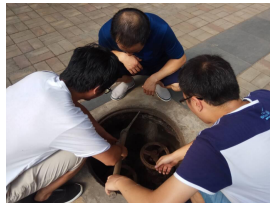
供暖主管道阀门更换工程
