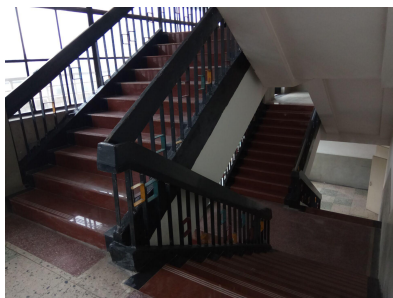
完工后的教学大楼楼梯踏步
