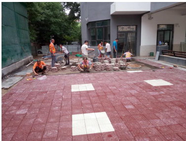
附属学校南侧铺地砖
