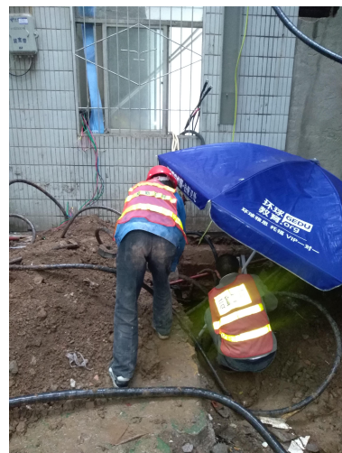
室外电缆沟施工
