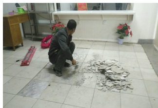
浴室地砖拆除
