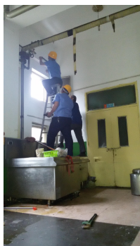
抢修学生食堂上水管道
