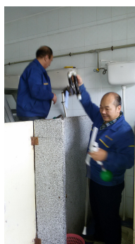
检修公寓水箱洁具
