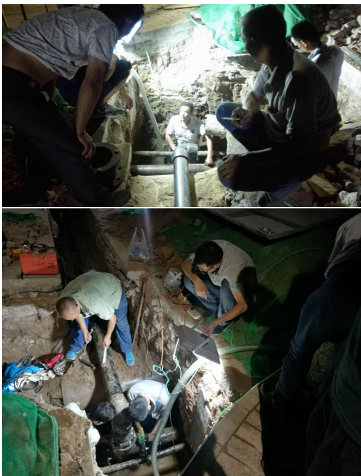
附属中学新建教学楼上下水管道施工正在紧张进行。闫总和周边开发办领导到现场指挥，直到晚上两点依然坚持抢修。
