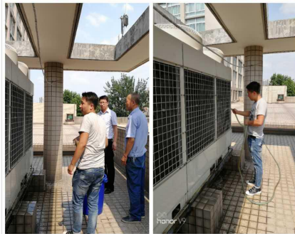
为了保障三楼报告厅空调制冷，闫总带领大家在五楼平台人工为空调降温
