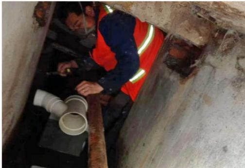
首先对厨房地面进行破拆，使得施工人员能够进入地沟，与此同时工程中心积极联系材料，及时将材料运送至施工现场，经过紧张的室内外同时作业，终于将砼地面破除干净，完整的将破损管道暴露出来。经过仔细排查后，发现是连接居民楼与室外上下水铸铁管道老化造成的堵塞和外溢。为防止污物影响业主正常生
