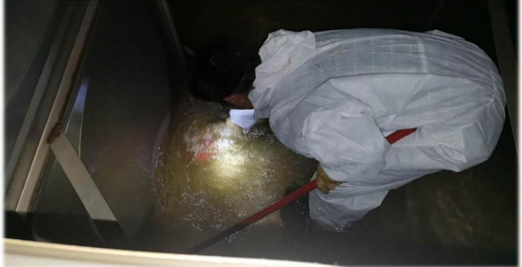
进行查看,确保水位正常供水。等到水位到达最低限位将水箱供水阀门关闭,开启泄水阀将剩余水排除,这样也有效的保障住户正常用水的同时也做到了节约用水。
